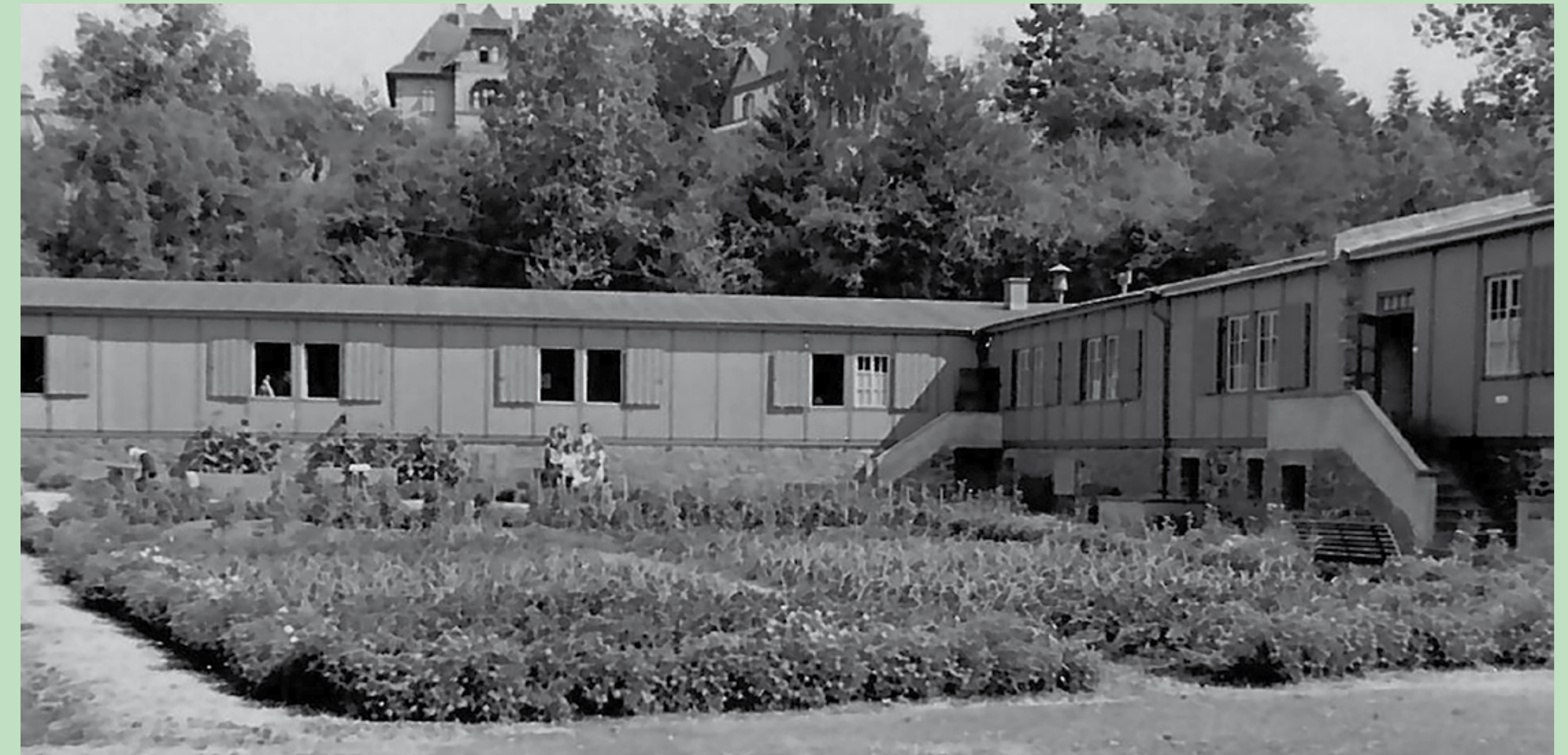
Die 1941 für italienische Arbeiter in L-Form errichtete Baracke. Heute steht noch der rechte Flügel.
